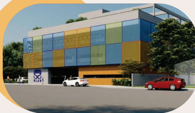
Fachada do novo prédio do Centro Lenira
